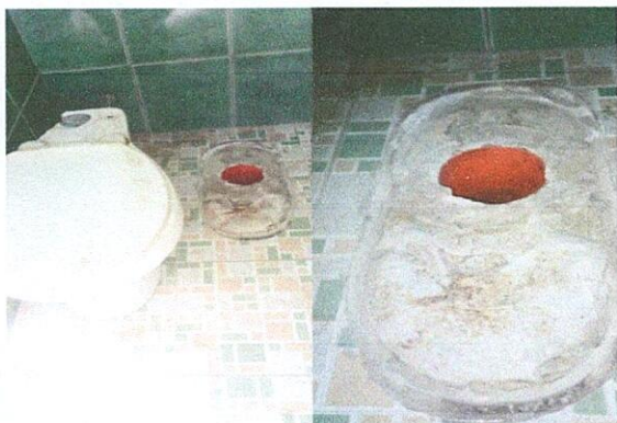
Foto1: levantado de santarios, pintado de puertas y paredes.
