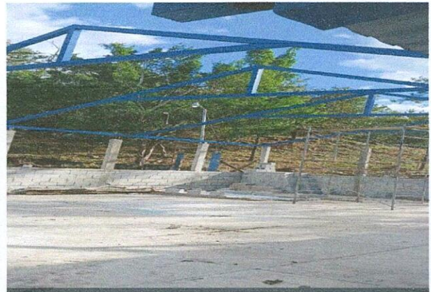
Foto4: Estructura metálica de la cancha.
