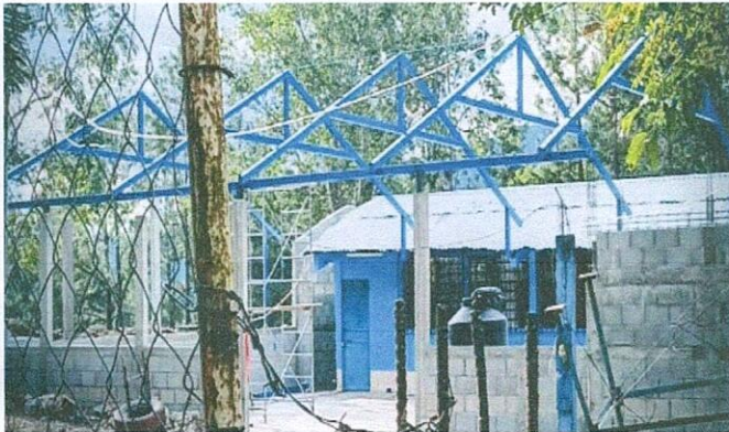
Foto3: estructura metálica del techo del salón de usos múltiples.
