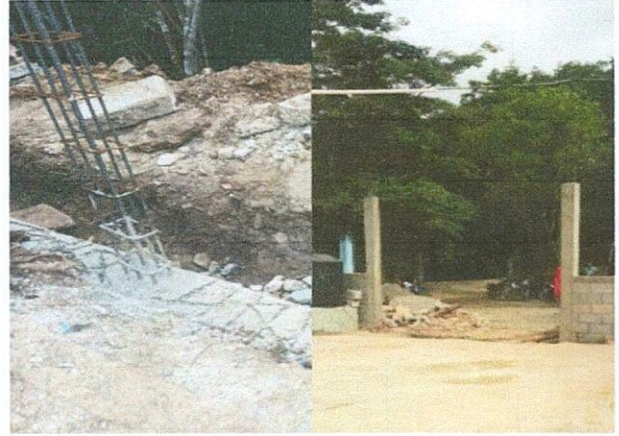
Foto2: durante el trabajo de mejoramiento del portón se fundieron nuevas columnas.
